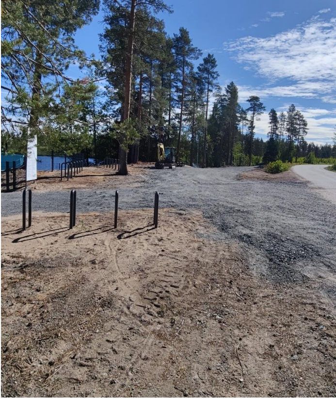
Kuva 8. Pysäköintialue, pyörätelineitä ja ilmoitustaulu.
